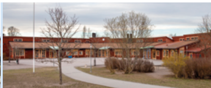
Nåntunaskolan, Uppsala. Utbyte och installation av skolans brand- och utryckningslarm.
